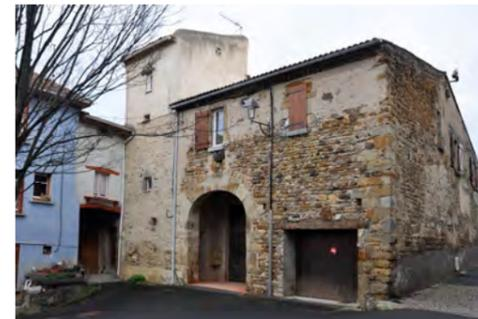
Partie arrière ouvrant sur un espace public traitée de manière peu respectueuse du contexte et du support (cimentage, percements et menuiseries inappropriées, disparition d'un élément sculpté médiéval énigmatique).
