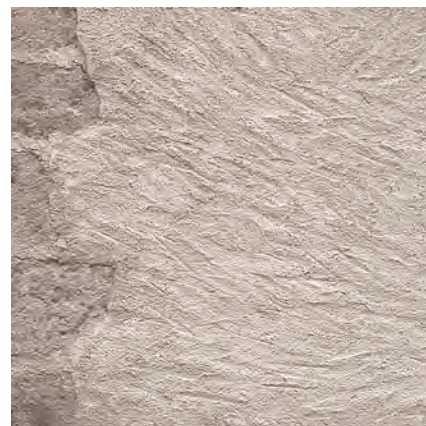
Exemples de différentes textures d'enduit, adaptées aux typologies anciennes
