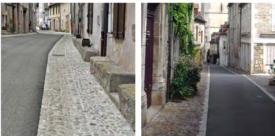
Exemples de matériaux combinés (ici pierre locale et béton bitumineux). Sur le cliché de gauche on notera que le «grenailage» a éclairci le sol de la chaussée.
