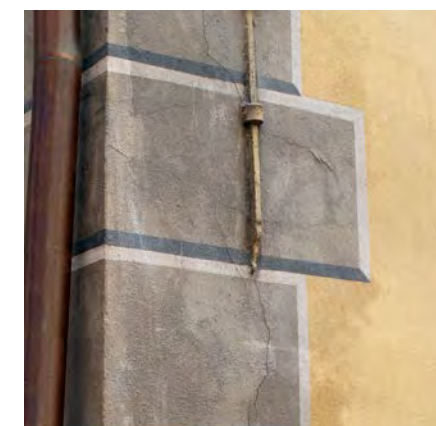
Finition simple et décors réalisés à l'aide de badigeon (à utiliser plutôt pour des patrimoines classiques ou néoclassiques)
