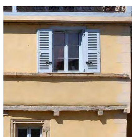
Manière de traiter les pans de bois avec un enduit (badigeonné ou coloré)
