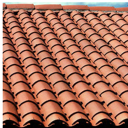
Principe de la tuile canal (aussi appelée tuile creuse, ou "tige de botte")
