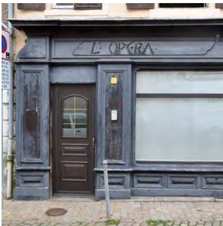
Devanture en “applique” : une baie uniquement fonctionnelle est dissimulée par un coffrage en bois , formant un cadre décoratif.
