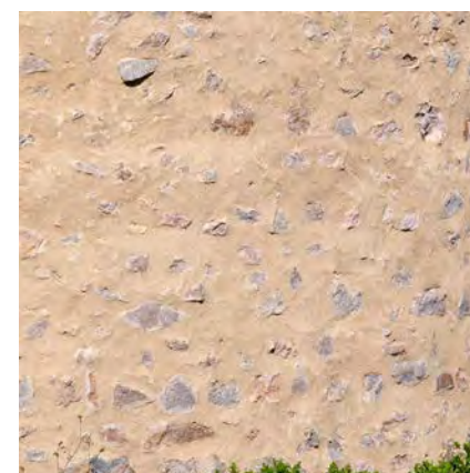
Exemples d'aspects à "pierre mi-vue" ou enduits "beurrés", adaptés aux types ruraux ou anciens volontairement "archaïques".
