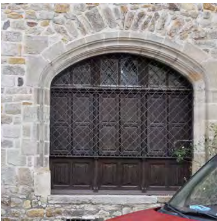
Devanture en “feuillure” : la baie à usage commercial ou artisanal est constituée d’une arcade en général ornée d’une moulure. L’arcade est ici dite «en anse de panier»
