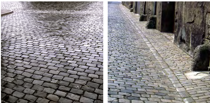
Le pavé dit "échantillon" (14 cm, 6 faces éclatées) et le pavé dit "boutisse" (14x30x14), posés sur sable, ont été les plus utilisés dans l'aménagement des villes de la fin de l'Ancien Régime au milieu XXe siècle.
