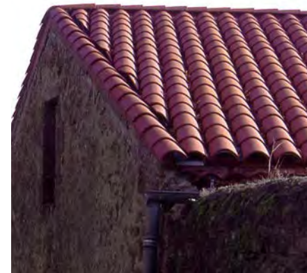
La pose de tuile "canal" sur forme ondulée : on ne doit pas percevoir la forme ondulée et des astuces sont parfois nécessaires en pignon pour traiter les biais...
