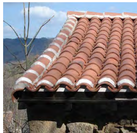
Principe de la tuile canal (aussi appelée tuile creuse, ou "tige de botte")
