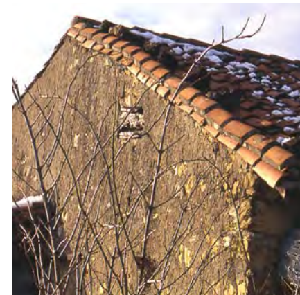
Principe de traitement des rives en pignons dans les toitures de tuile canal en Auvergne.
