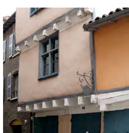
Manière de traiter les pans de bois avec un enduit (badigeonné ou coloré)
