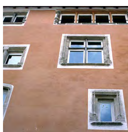
Manière de traiter les façades de type ancien avec un enduit (lisse).
