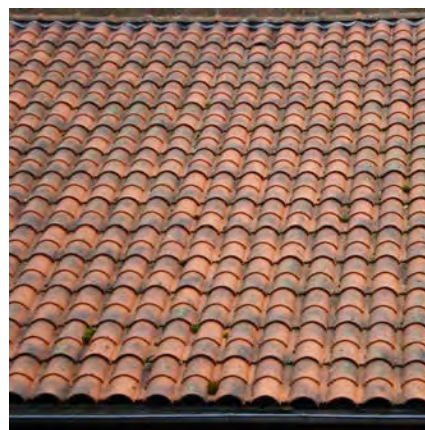
La tuile "romane", qui est une tuile à emboîtement, et qui diffère de la tuile "canal".
