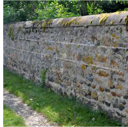
Type de clôture maçonnée très répandue à Billom (et dans les Limagnes) dont le couronnement est maçonné.
