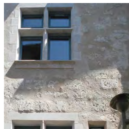
Exemples d'aspects à "pierre mi-vue" ou enduits "beurrés", adaptés aux types ruraux ou anciens volontairement "archaïques".
