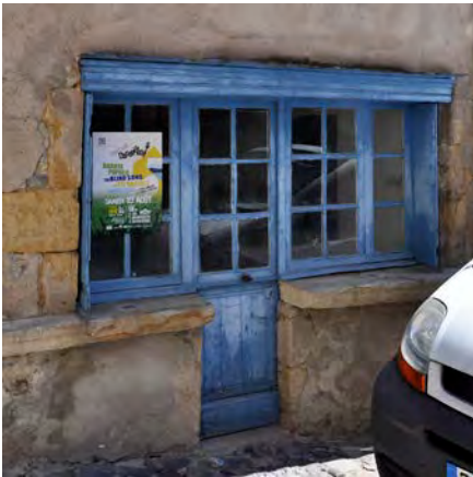
Ce peut être aussi une simple baie menuisée sous un linteau constitué d’une poutre en bois.
