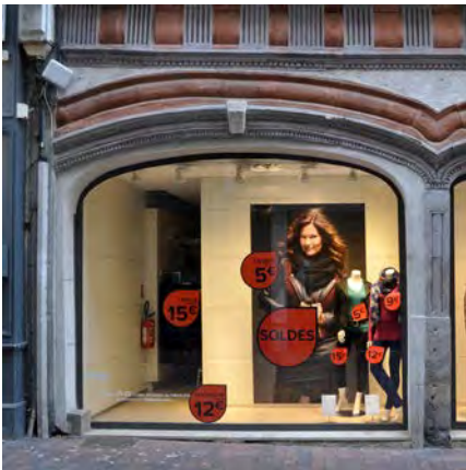
Exemple de boutique moderne dans une baie ancienne en anse de panier. (en SPR couvert par un PSMV, sur un MH)
