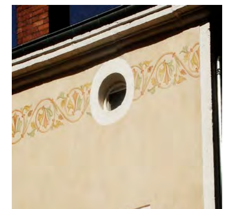
Finition simple et décors réalisés à l'aide de badigeon (à utiliser plutôt pour des patrimoines classiques ou néoclassiques)
