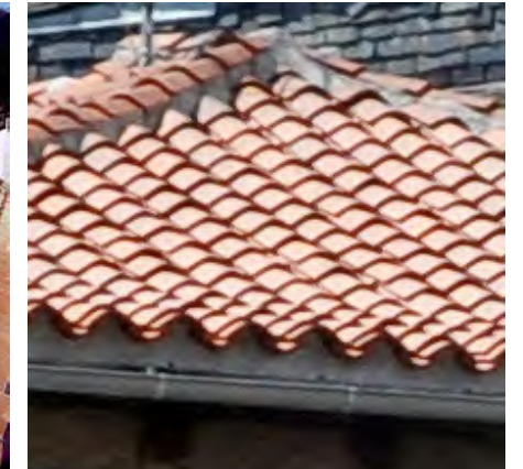
Façades traditionnelles en tuiles de couvert scellées au mortier de chaux.
