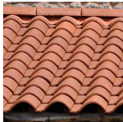
La tuile "romane", qui est une tuile à emboîtement, et qui diffère de la tuile "canal".
