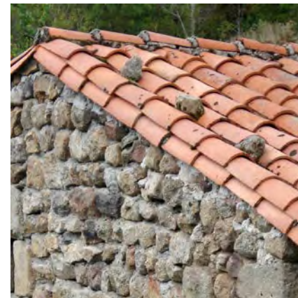
Principe de traitement des rives en pignons dans les toitures de tuile canal en Auvergne.
