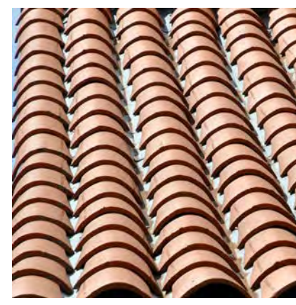
La pose de tuile "canal" sur forme ondulée : on ne doit pas percevoir la forme ondulée et des astuces sont parfois nécessaires en pignon pour traiter les biais...
