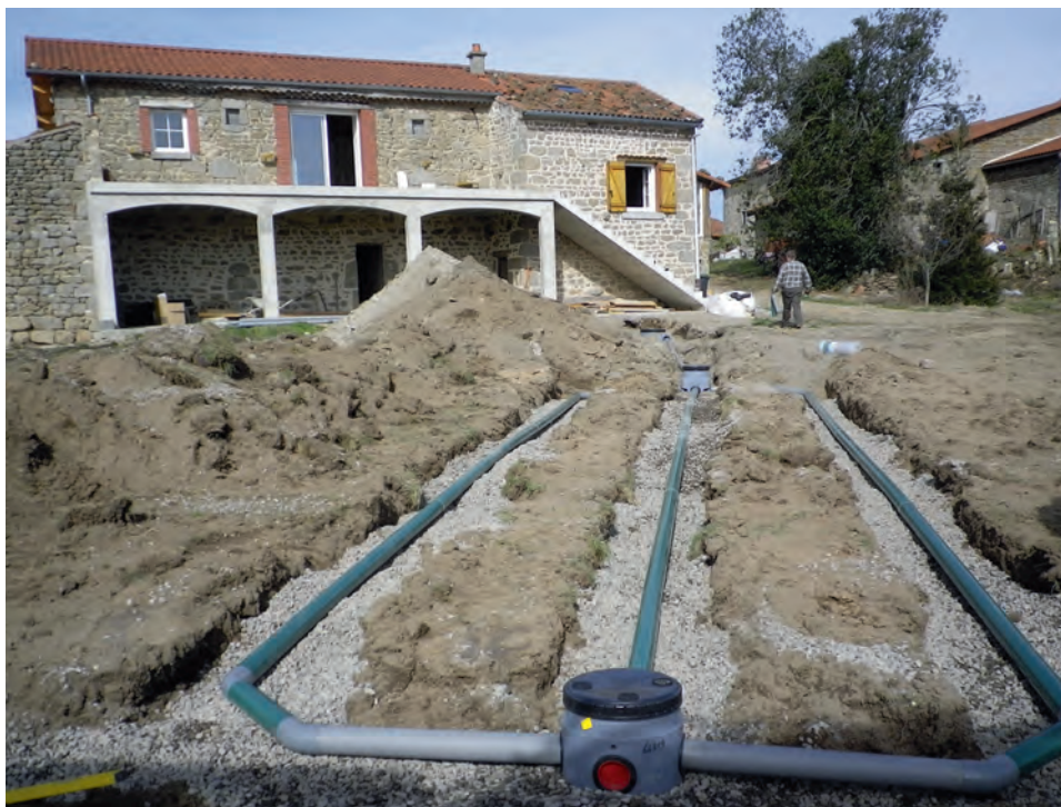
Travaux de réalisation d'un ANC
