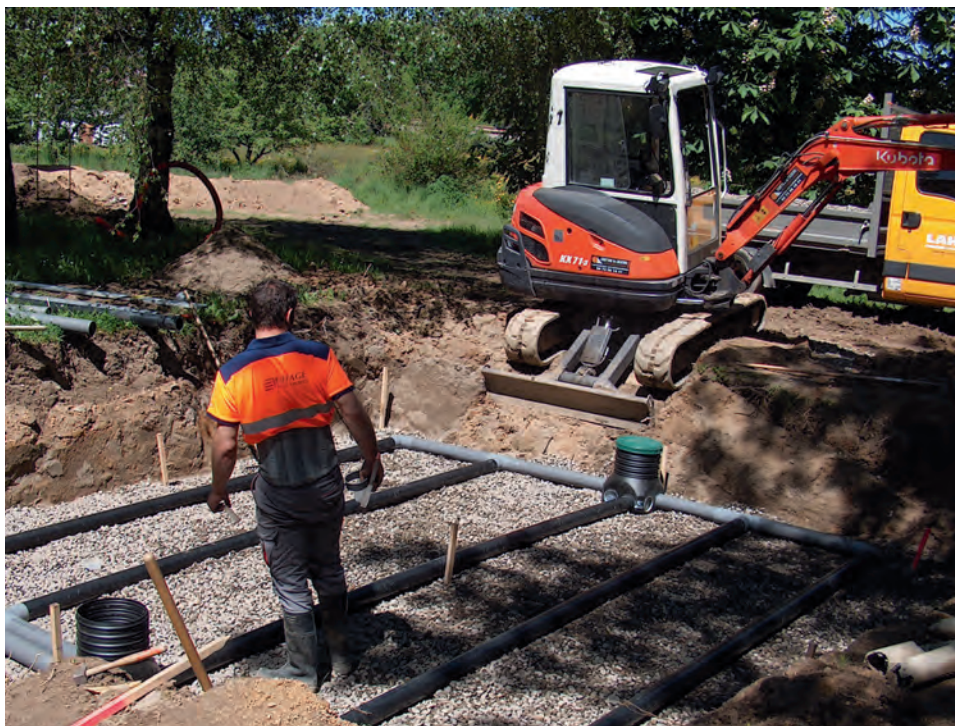
Travaux de réalisation d'un ANC
